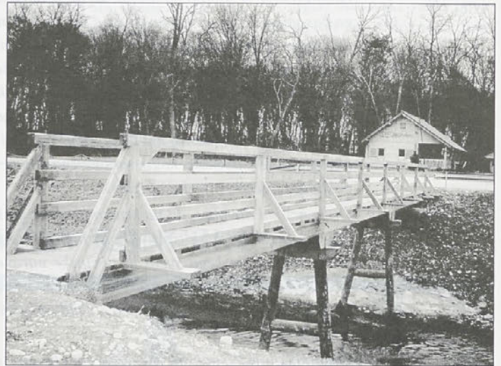
Nov most čez Rogoznico v Zabovcih vodi neposredno do tamkajšnjega športnega parka.
