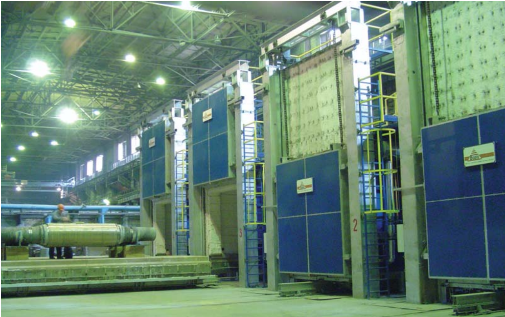
Največji projekt podjetja: štiri peči za termično obdelavo litih valjev (Rusija)
