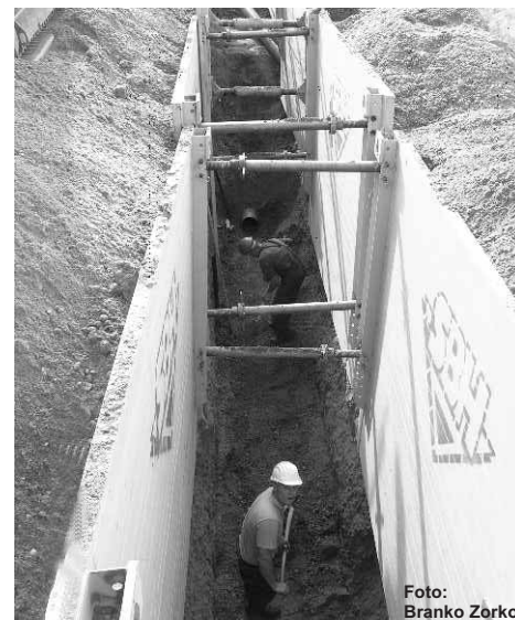
Izvedba kanalizacijskega voda 3,5 metra pod terenom cestišča
