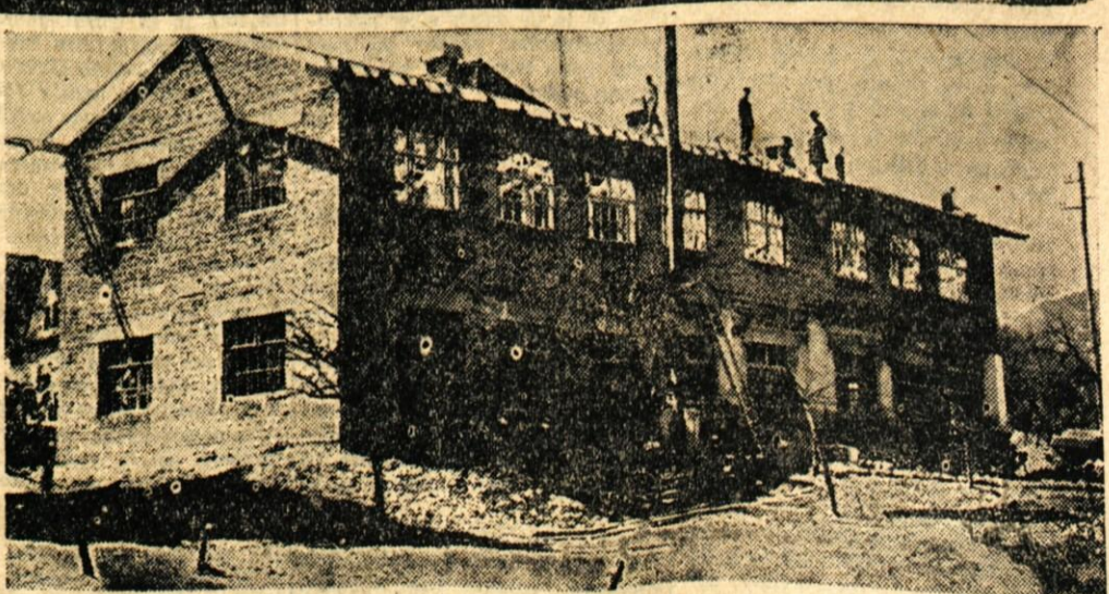
Pri novi zgradbi, ki bo stala na temeljih nekdanje enonadstropne hiše v dveh traktih, pravkar končujejo z deli na ostrešju. H gradnji bo podjetje samo prispevalo 40 odstotkov vseh sredstev, ostalo pa bodo črpali iz drugih virov. (J. Z. - Foto: F. Perdan)
