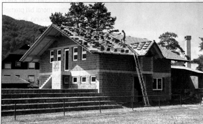
V prejšnjem tednu je objekt pri mozirskem nogometnem igrišču končno dobil streho (foto: Benjamin Kanjir)
