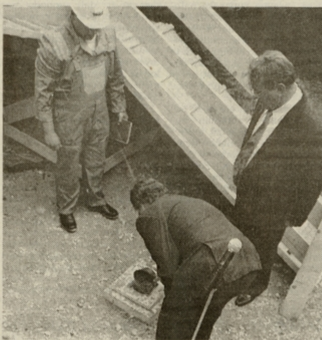
Med polaganjem temeljnega kamna so je po dolgem času vili dež. »Nebo se je vsekoli smejalo, sedaj pa se ne smeje več. Dež pa lahko pomeni tudi, da bodo tla medsebojnega poslovanja zelo plodna,« je omenil Wörner med polaganjem kasete.
