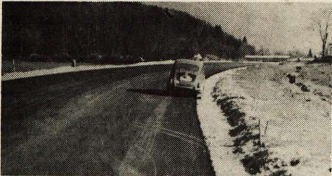
Kranjska gora — Delavci Cestnega podjetja Kranj so minuli teden položili asfalt na novi del ceste od Kranjske gore do Podkorena. Zdaj urejajo še bankine, predvidoma ob dnevu republike pa bodo cesto odprli. — Foto: B. B.
