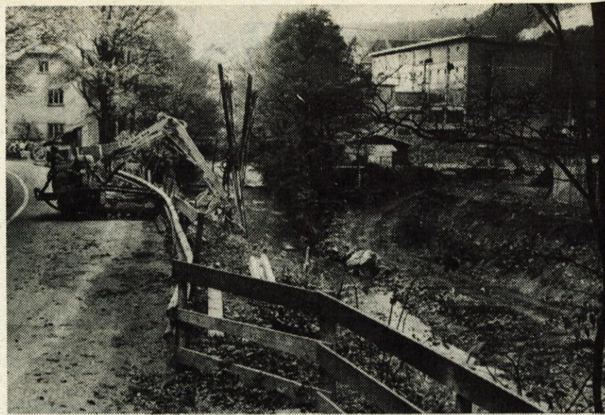
Nov most v Tržiču - K urejevanju upadne ceste v Tržič sodi tudi gradnja novega mostu čez Tržiško Bistrico. Delavci Gradbinca so s pripravljalnimi deli že končali. Računajo, da bo nov most, ki bo odstranil enega največjih tržiških prometnih problemov, zgrajen za prihodnji občinski praznik 5. avgusta. Gradnja mostu terja združevanje sredstev republiške skupnosti za ceste, denarja iz sklada za negospodarske investicije tržiške občine in sredstev zadnjega samopriskpeva v tržiški občini. (jk) - Foto: F. Perdan
