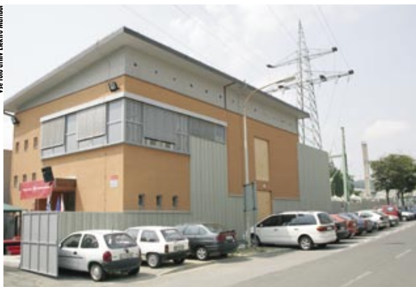
Nova stavba RTP Melje.
