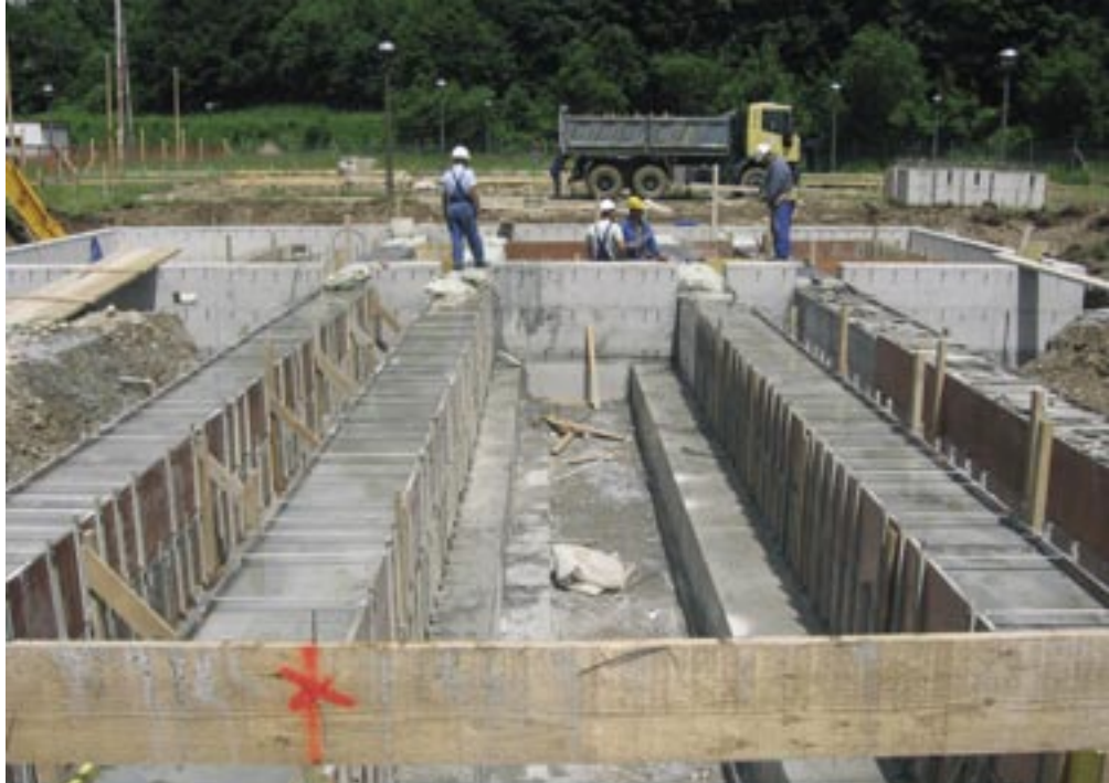
Priprava temeljev za nov transformator.
