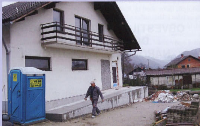
Dela v prostorih nekdanje trgovine na Senici, kjer bosta dva oddelka vrta, intenzivno potekajo. Prestavili so tudi že vhod v vrtec ter do njega zgradili klančino.
