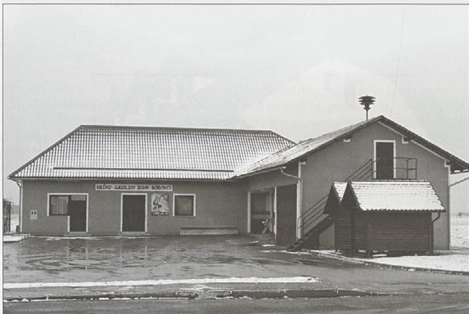
Tudi gasilski dom v Borovcih je obnoven.
