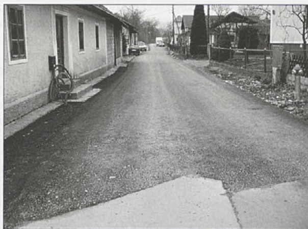
Groba asfaltna prevleka v naselju Markovci.
