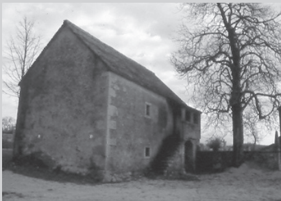
5. Križ pri Sežani, mežnarija ob cerkvi sv. Križa. Stavba je zidana iz kamna in pokrita s "škrlami", močno ostrešje je sestavljeno iz hrastovih tramov
