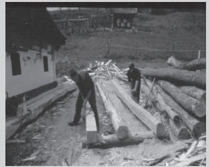
7. Muzej na prostem Rogatec. Tesarji pripravljajo kostanjev les za strešno konstrukcijo
