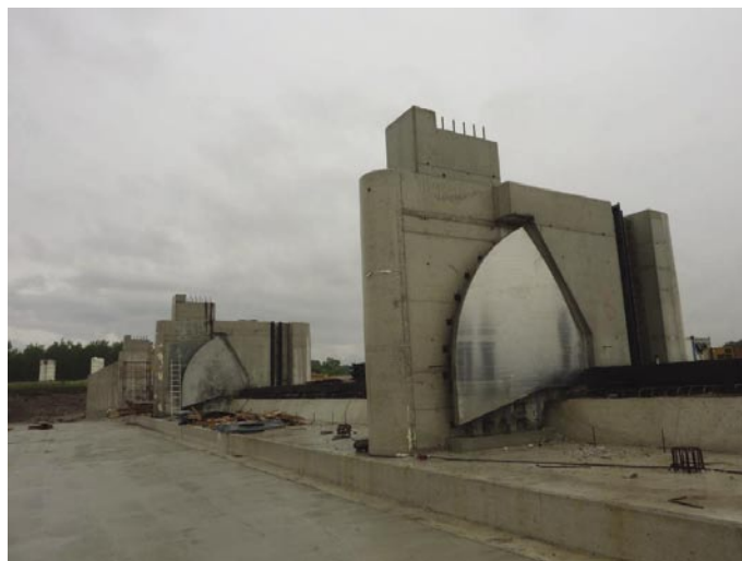
Slika 2 • Najprej smo si ogledali gradbišče visokovodnega preliva na levem bregu bodočega bazena. To bo prvi objekt takšne vrste v Sloveniji, podoben je načrtovan tudi v bazenu HE Mokrice
