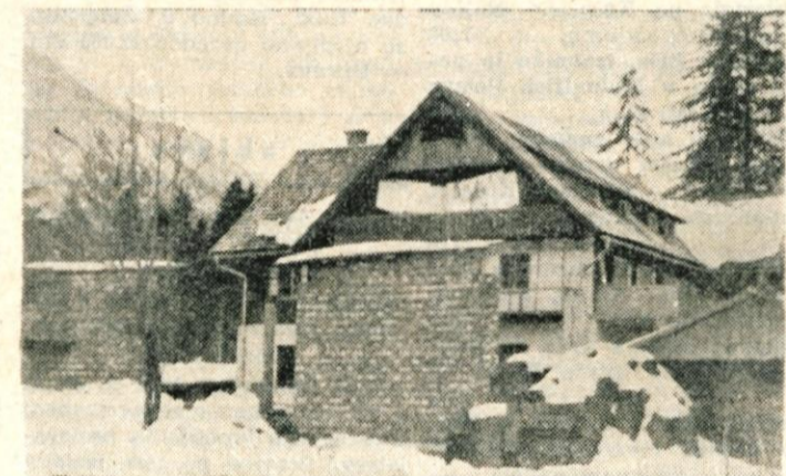
Pri hotelu »Jezero« gradijo novo restavracijo
