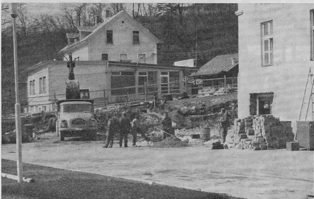
Gradbišče nove upravne stavbe — globoka gradbena jama
