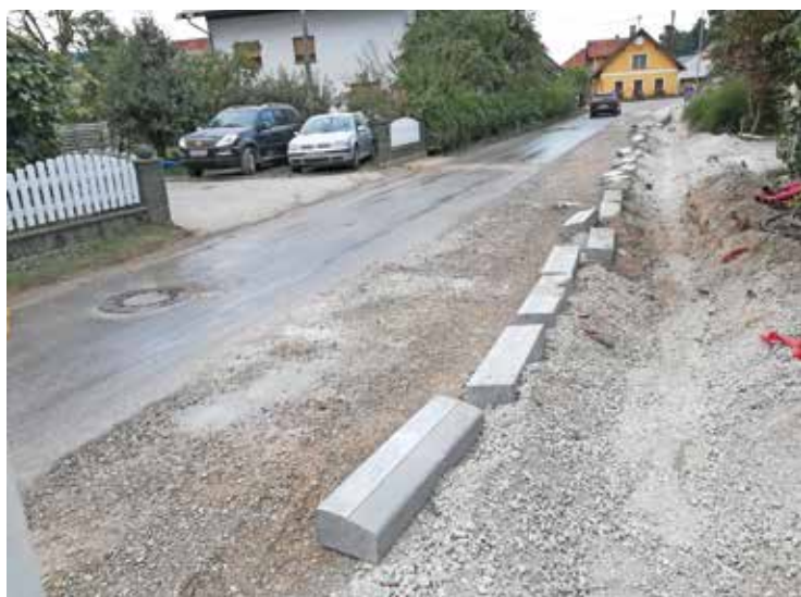
Cesta in pločnik v gradnji
