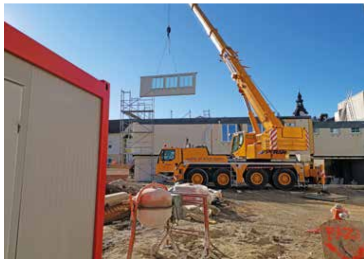
Dela na prizidku k OŠ Ig
