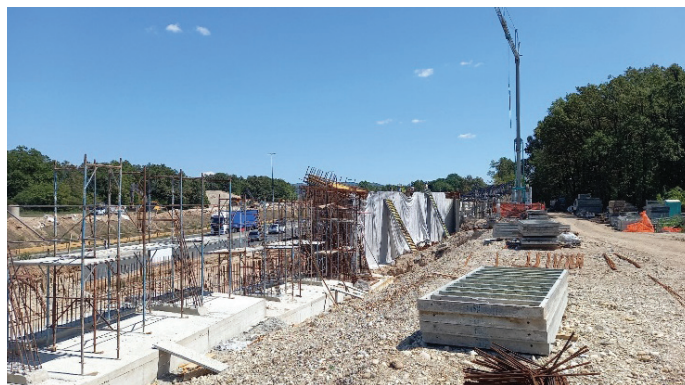
Slika 7. Dela na nadvozu nad krakom C (nov izvoz iz HC) in južni servisni cesti, avgust 2022.
