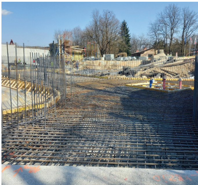
Slika 5. Temeljenje, južno krožišče, marec 2022.
