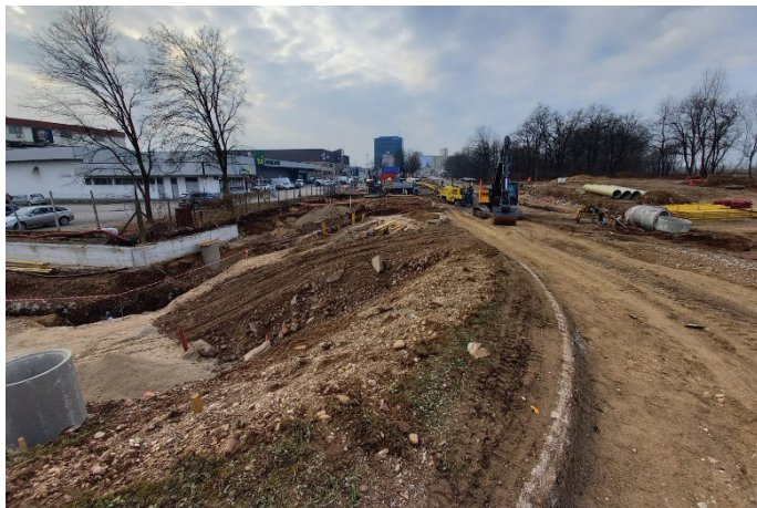
Slika 3. Pripravljalna dela, pogled na Leskoškovo zahod, november 2021.
