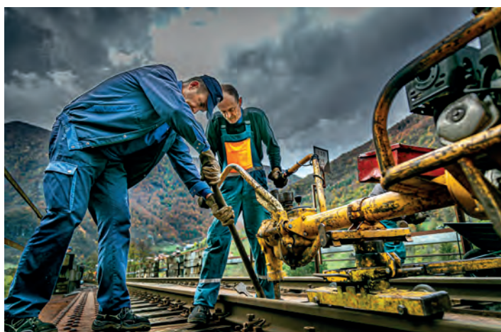
Med deli so zaposleni SŽ-Infrastruktura zamenjali vse pragove in tir geometrijsko uredili.
