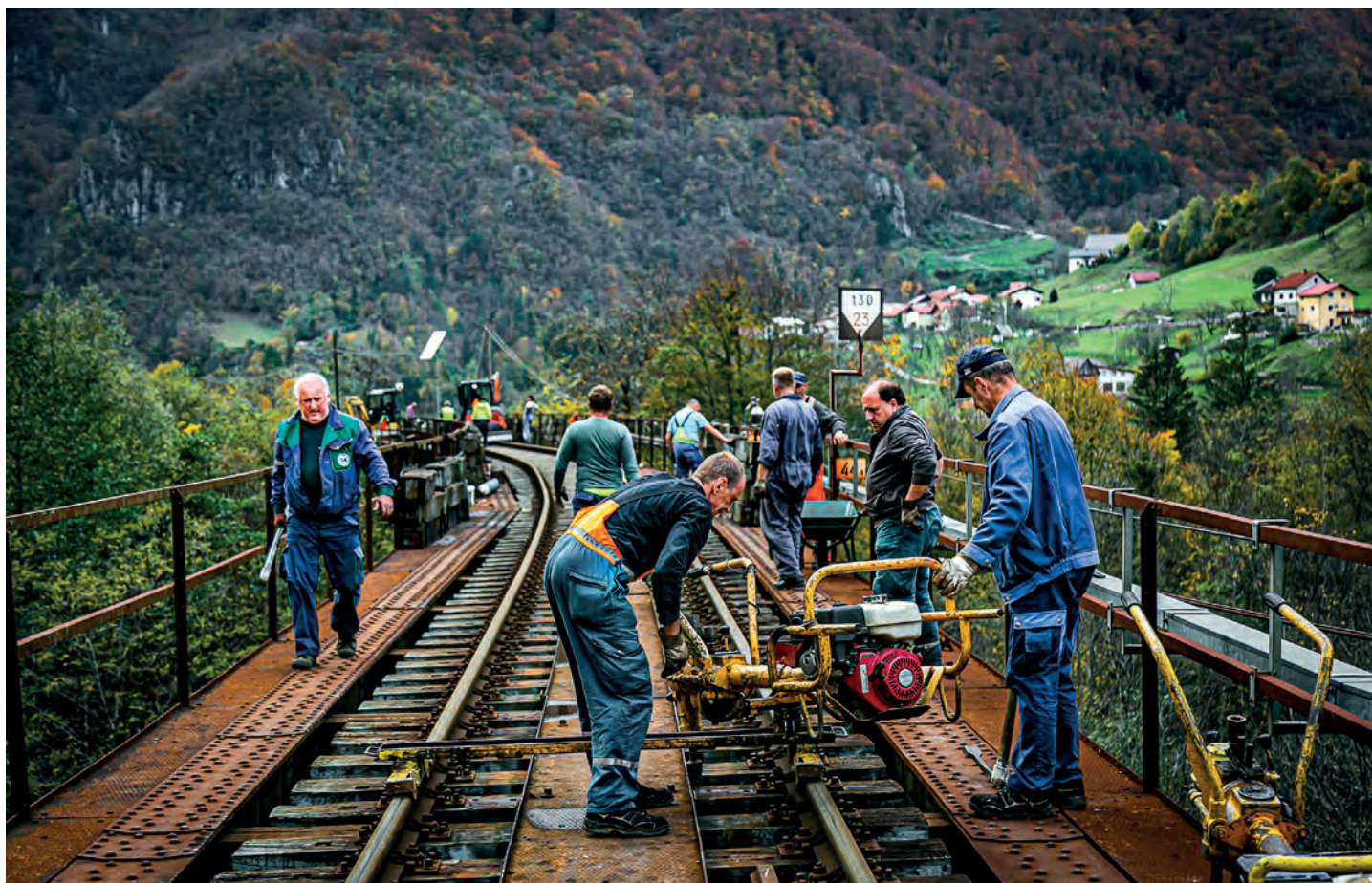
Dela na viaduktu Bukovo ob reki Bači
