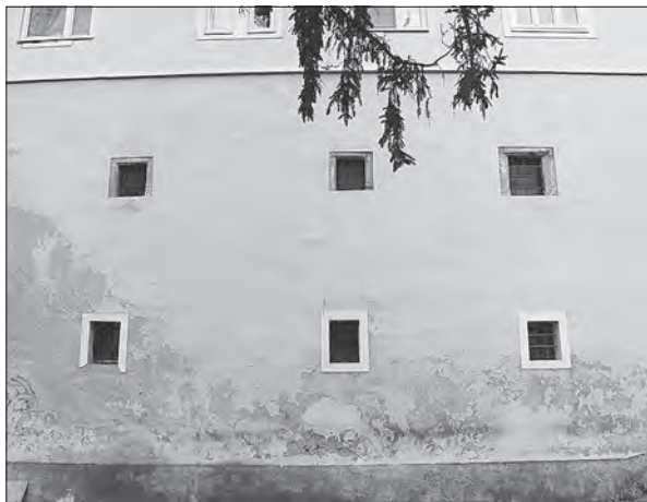
Zunanja fasada vzhodnega trakta s tremi poznogotsko profiliranimi kamnitimi okenskimi okviri iz prve polovice 16. stoletja v pritličju oziroma drugi etaži (foto: Igor Sapač, 2024).
