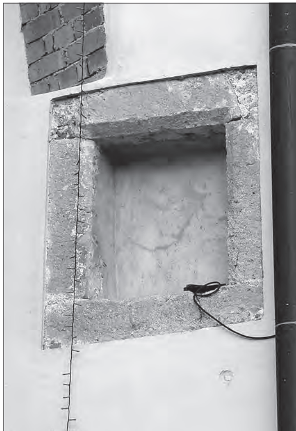
Pznogotski kamniti okenski okvir iz prve polovice 16. stoletja v prvem nadstropju severovzhodnega stolpa (foto: Igor Sapač, 2024).
