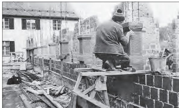
Gradnja pritličnih arkad nadomestnega severnega trakta leta 1990 (fotografiji iz zasebne dokumentacije Igorja Sapača).
