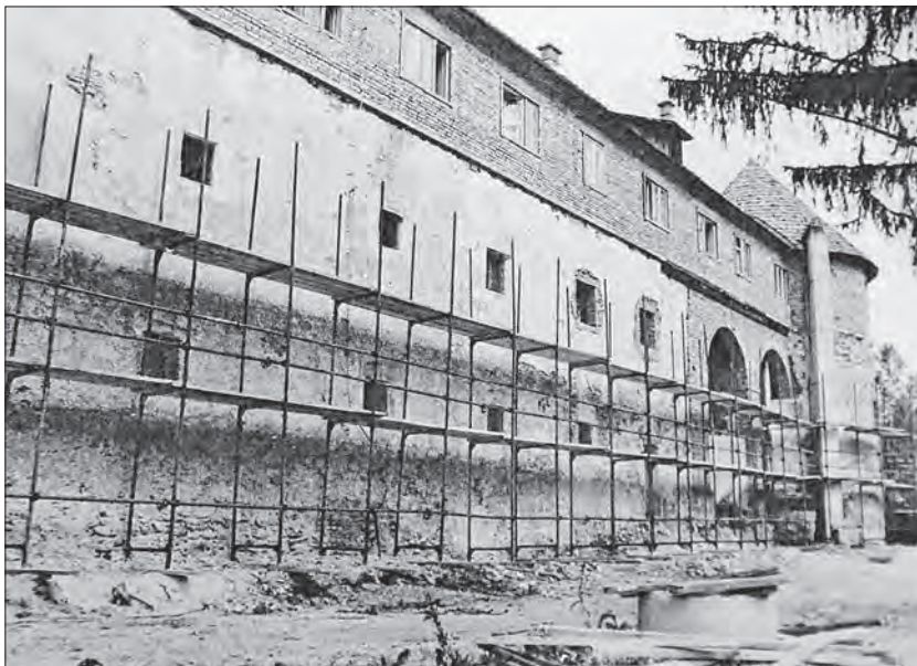
Obnova zunanjsčine vzhodnega trakta okoli leta 1988 (fotografija iz zasebne dokumentacije Igorja Sapača).
