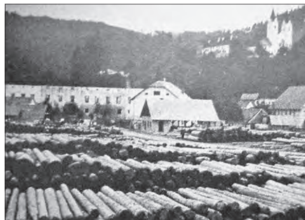
Pogled na požgani grad z zahodne strani, z območja velikega lesnopredelovalnega obrata, leta 1945 (Bajt et al., Slovenska kronika, str. 166).
