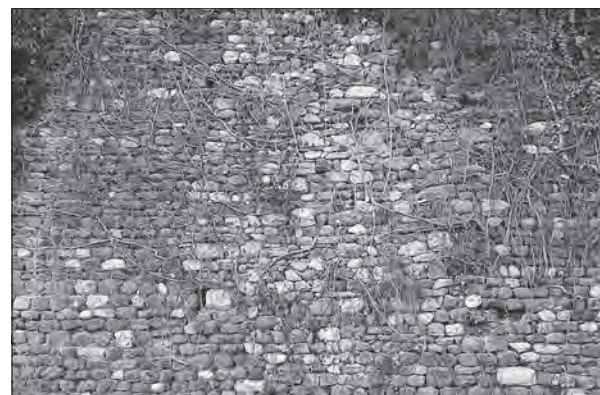
Detajl zidovja na jugovzhodni strani nekdanjega grajskega jedra (foto: Igor Sapač, 2016).
