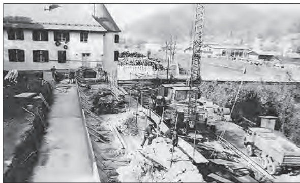
Pogled na začetek gradnje nadomestnega severnega trakta leta 1990 (fotografija iz zasebne dokumentacije Igorja Sapača).
