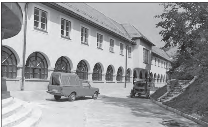
Pogled na dvoriščno stran nadomestnega severnega trakta ob zaključku njegove gradnje (foto: Igor Sapač, 1991).
