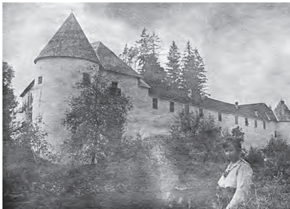
Severna fasada gradu Vrbovec z nizom oken, ki so nastala z zazidavo prvotnih arkadnih odprtin, na fotografiji iz okoli leta 1925 (zasebna zbirka).
