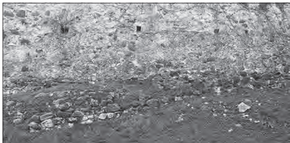
Struktura zidave ostanka starejšega srednjeveškega zidovja, ki sega pod novoveško jugovzhodno stranico grajskega dvoriščnega obzidja (foto: Igor Sapač, 2024).
