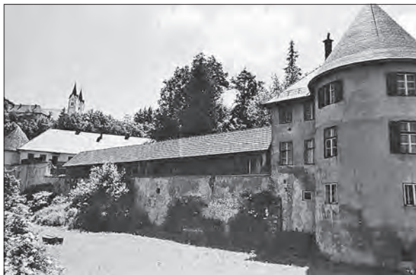
Pogled na severno stran grajskega kompleksa okoli leta 1987, pred gradnjo nadomestnega severnega trakta (fotografija iz zasebne dokumentacije Igorja Sapača).
