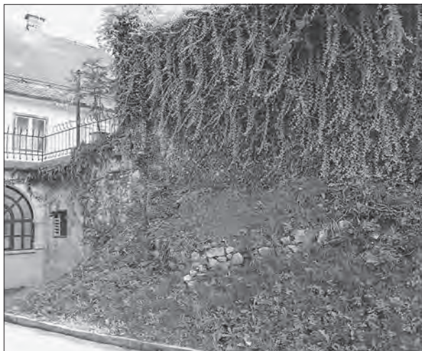
Skromni ostanki zidovja nekdanjega visokega gotskega valjastega glavnega grajskega stolpa na severovzhodnem koncu grajskega jedra leta 2016 (foto: Igor Sapač).
