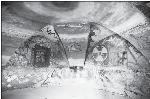
S sosvodnicami razčlenjeni kupolasto obokani kletni prostor v prvi polovici 16. stoletja zgrajenega jugozahodnega stolpa (foto: Igor Sapač, 2024).
