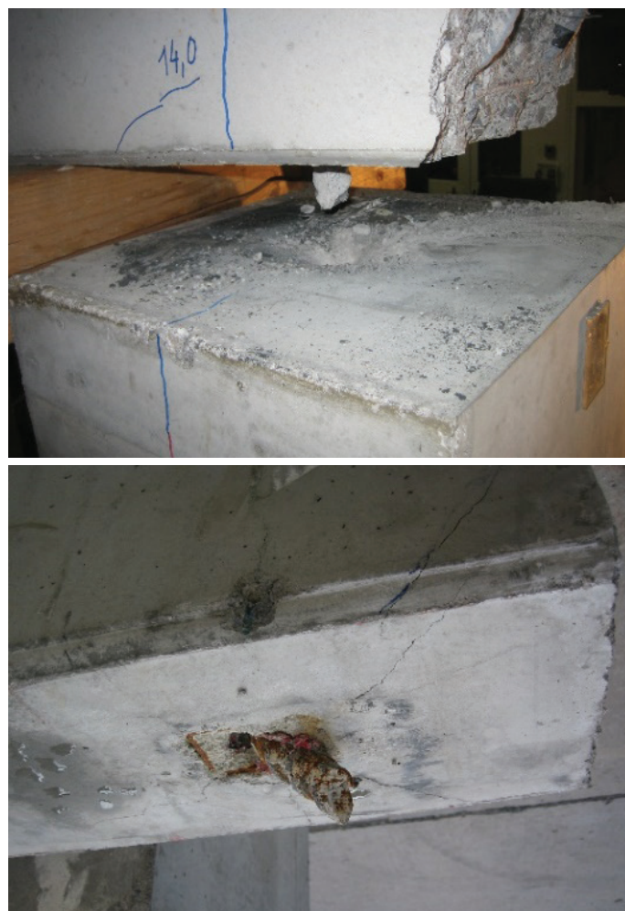
Slika 3. Lokalne poškodbe in lokalna porušitev mozničnega stika.
