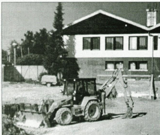
Gradbišče prizidka k šoli na Vidmu
