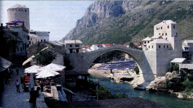
Ponovno zgrajeni most
