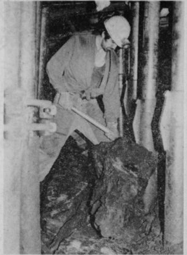
Klasična odkopna metoda – razkosavanje velikih kosov lignita
