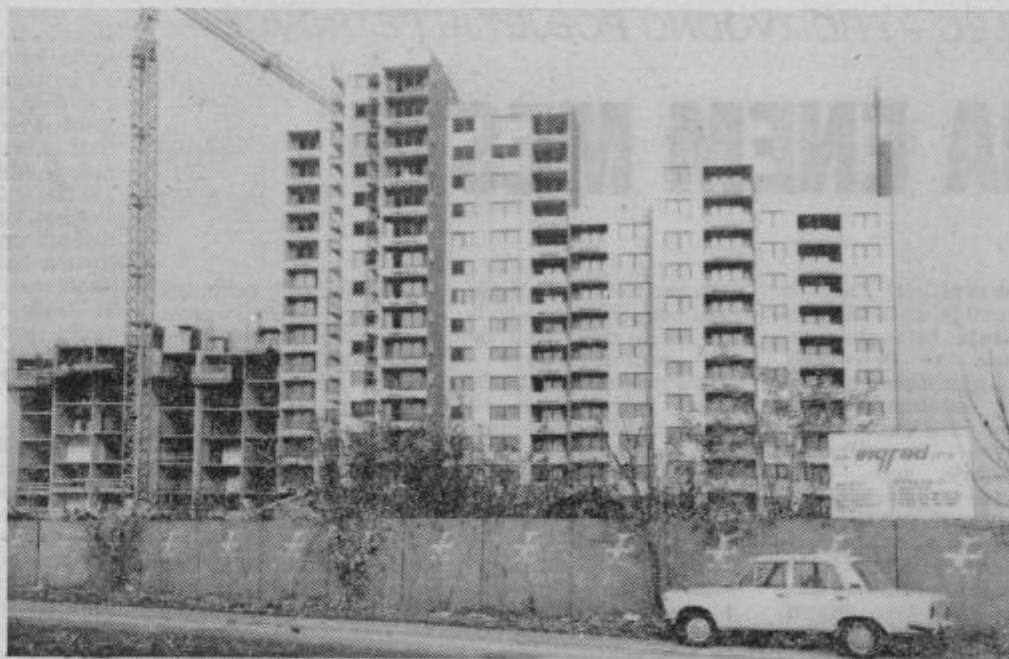
V verižni zazidavi Otok III-S bo 246 stanovanjskih enot
