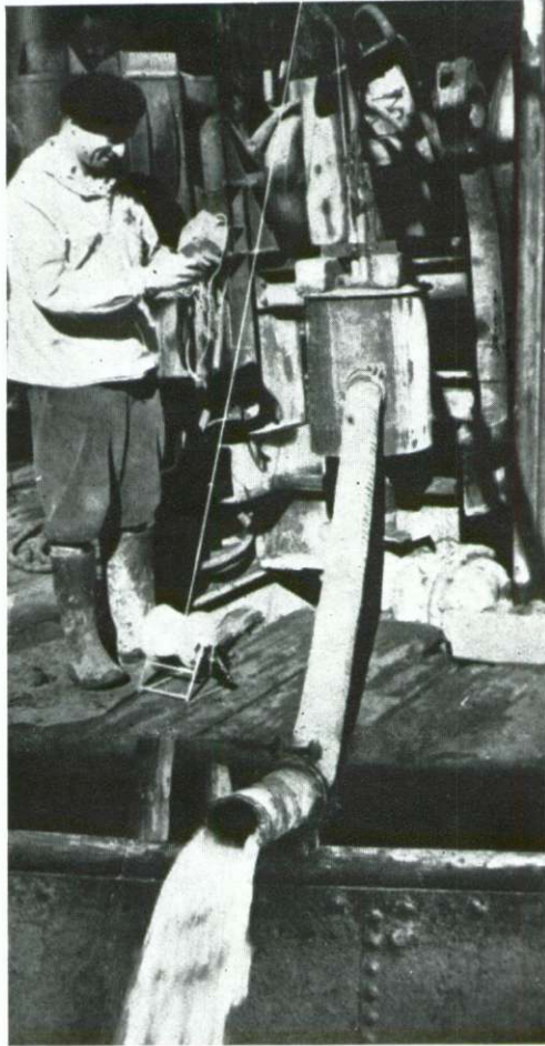
2. sl. Črpalni poizkus na vrtini II/2 v osrednjem delu šaleške kadunje
