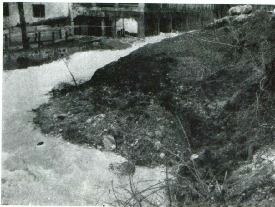
4. sl. 13. decembra 1959 je plaz segel že v strugo Tržiške Bistrice Fig. 4. On 13th of December 1959 the earth slide reached in the river bed of Tržiška Bistrica
