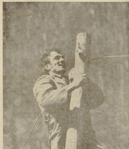
Gradnja novih žičnic je končana. Pregledati, popraviti in napeti je treba vse stare, da ne bo poznejših okvar
