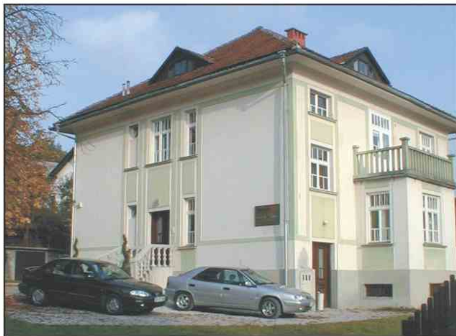
V novi poslovni stavbi podjetja Trend Net na Šlandrovi 6a, ki so jo uredili v prostorih bivšega Vegradovega projektivnega biroja, so pred kratkim v pisarne preuredili tudi podstrešje.
