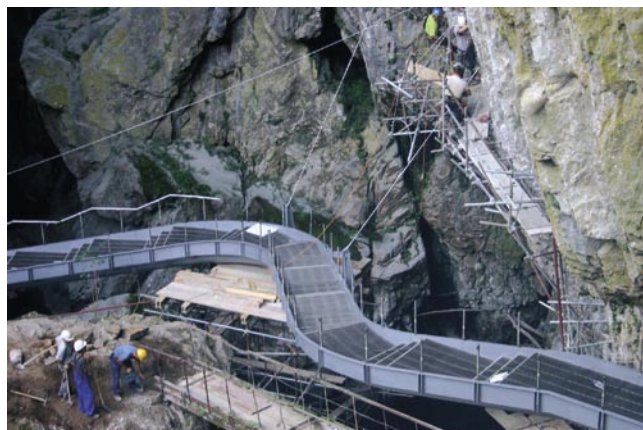
Slika 14 • Namestitvev jeklenih zateg, krovne konstrukcije in opreme
