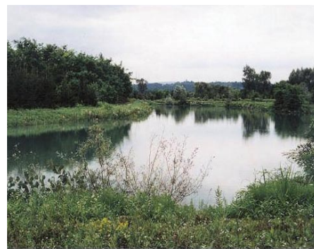
Slika 14 • Zemeljski bazen za varnostno zalogo vode in bogatenje podtalnice na črpališču Mihovci vodovoda Ormož
