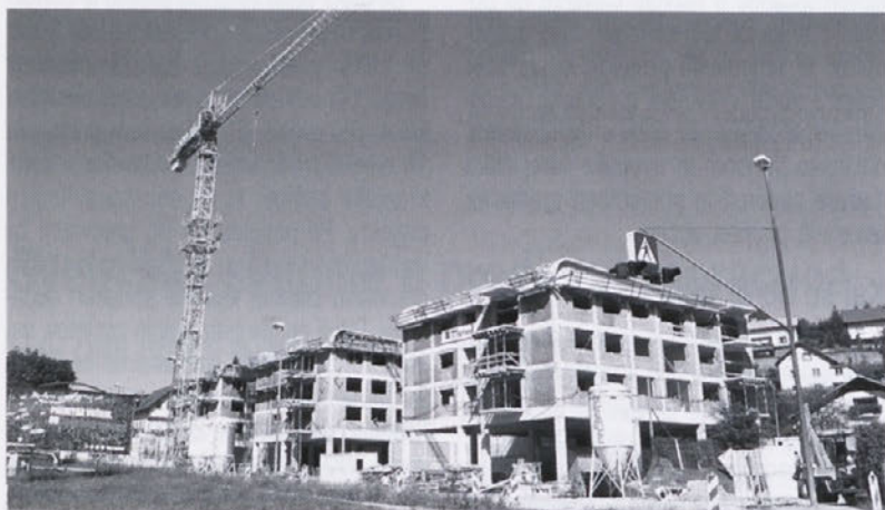
Novomeško podjetje Real je letos v uporabo predalo nov stanovanjsko-poslovni objekt na Seidlovi cesti, s čimer se je med ostalim izboljšala tudi ulična podoba.
