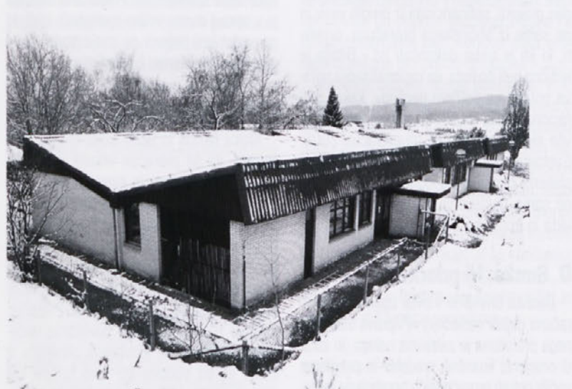
Vrtec Ostržek v Bršljinu se bo obnovil in dobil tri nove igralnice. V času obnove bodo otroci prerazporejeni v druge vrtce. Ostržek bo imel po obnovi 11 igralnic, večji skupni prostor ter potrebne tehnične in pomožne prostore. Vrednost celotne investicije je 1,6 mio evrov, dela bi se predvidoma začela poleti 2008, zaključila pa v letu 2009.
