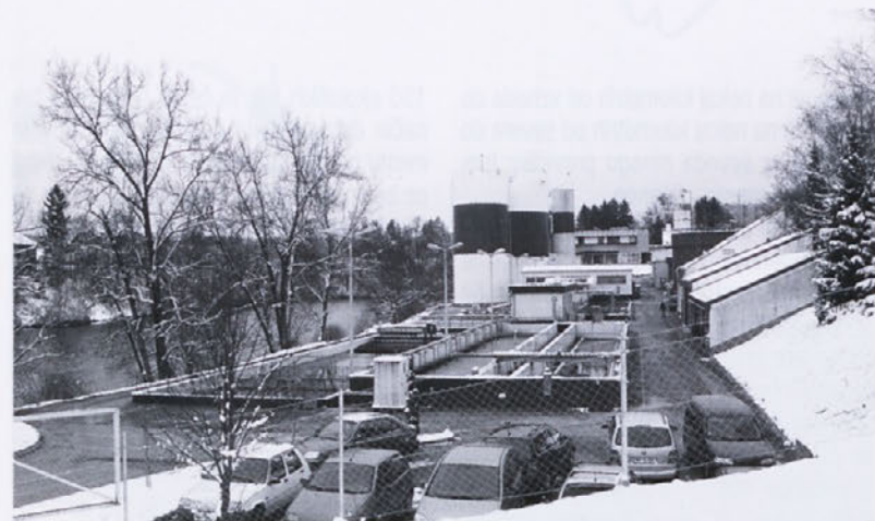
Centralno čistilno napravo v Ločni bodo nadgradili, poleg tega pa bo v prihodnjih letih prišlo do hidravlične izboljšave kanalizacijskega sistema v mestu. Vrednost projekta je 17 milijonov evrov, od česar bo MO NM prispevala 6,4 milijona, RS 1,4 milijona, kohezijski sklad pa 9,2 milijona. V letošnjem predlogu proračuna je predvidenih kar 1,9 milijona.
