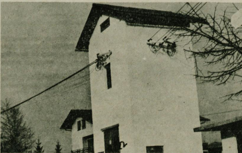
Lepo urejena transformatorska postaja, ki so jo s samoprispevkom zgradili naši občani. Žalostno pri tem pa je to, da bodo zastekljene površine kaj kmalu razbite, saj nekaterim so taki objekti močno napoti
