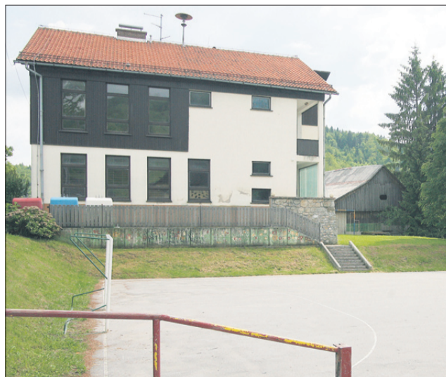
Hram učenosti na Svetini je že več let zaprt ter skoraj zagotovo ne bo nikoli več služil kot podružnična osnovna šola. Zanj iščejo novo namembnost.
