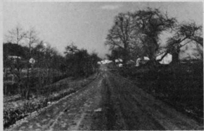
Cesta Zavrč—Drenovec kliče po modernizaciji Foto: I. kotar
