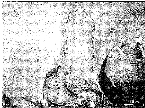
Sl. 6: S kondenzirano vlago razjeden strop vhodnega dela Trhlovce.
