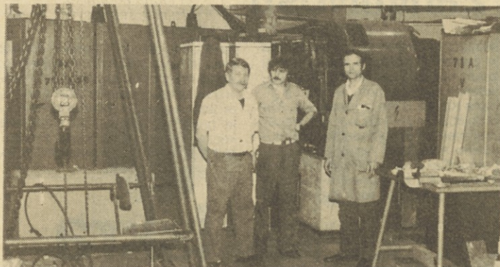
Marsikdo ne ve, da je v 16. nadstropju naše stolpnice velika strojnica za pogon in krmiljenje dvigal. Na sliki je na levi strani škripčevje za spust 800 kg težkih agregatov skozi strop, ker so jih morali previti. Od leve proti desni oba švicarska monterja: g. Johann Haas in Martin Lüchinger, zraven stoji strojnik Ivan Petek iz Invest servisa, ki dobro obvlada nemški jezik. (Foto: M. Kralj)
