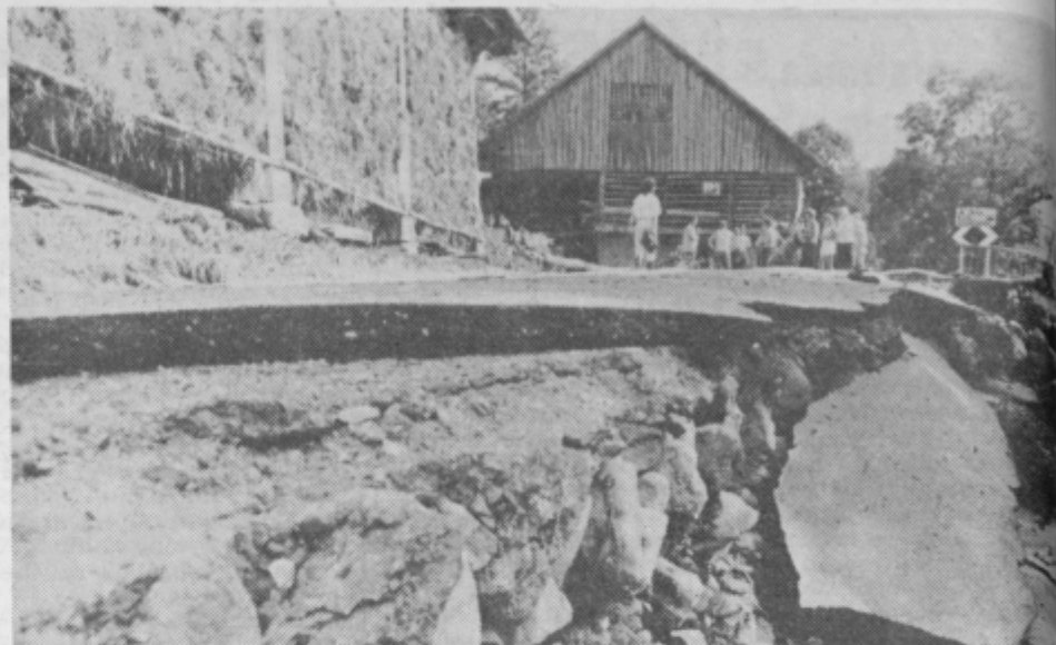
Od križišča in mostu, kjer ena cesta vodi v Reko in druga v Breze in Vrh nad Laškem, ostalo opustošenje. Cesto je voda prelomila na pol, most je spodkopan. Knezovi, katerih kmetija je ob cesti, so živino iz hleva rešili v zadnjem trenutku.
