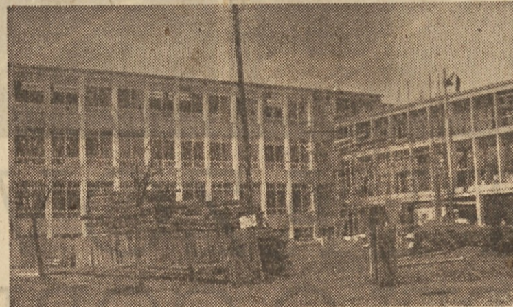
V kratkem bo dograjena tudi nova zgradba elektrogospodarske šole
