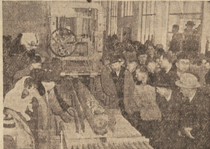
Moderni polnojarjenik v obratovanju
