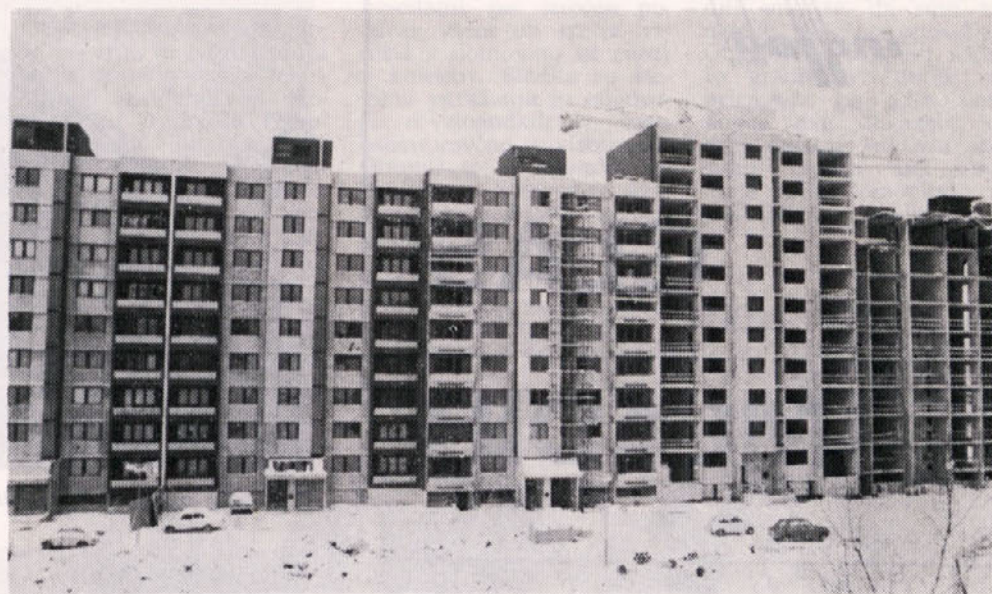
Stanovanjska soseska Nova vas Celje, v gradnji verižni blok
