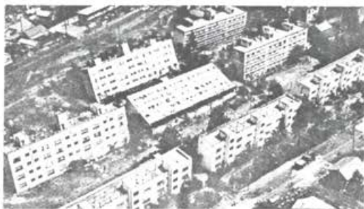
Tudi sodobni objekti so lahko žrtve potresa, če popustijo tla (Niigata na Japonskem, 1964)
