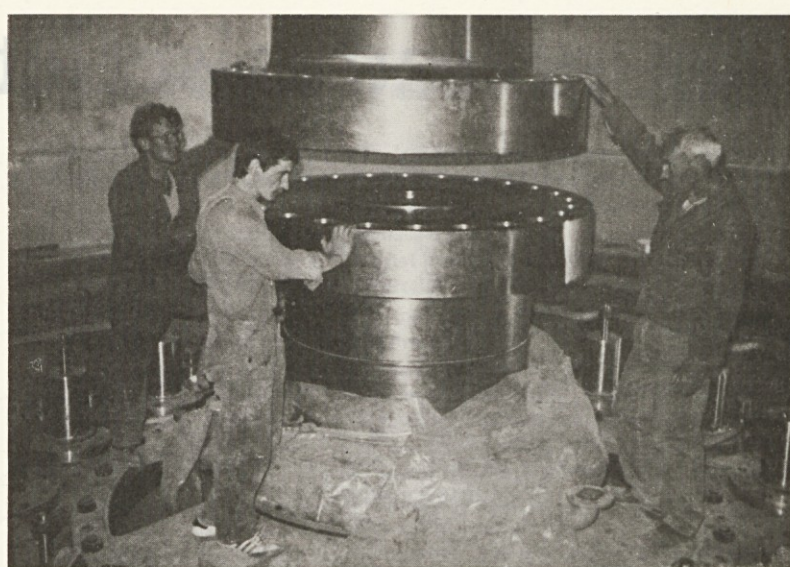
Spajanje turbinske in generatorske gredi v RHE Obrovac
