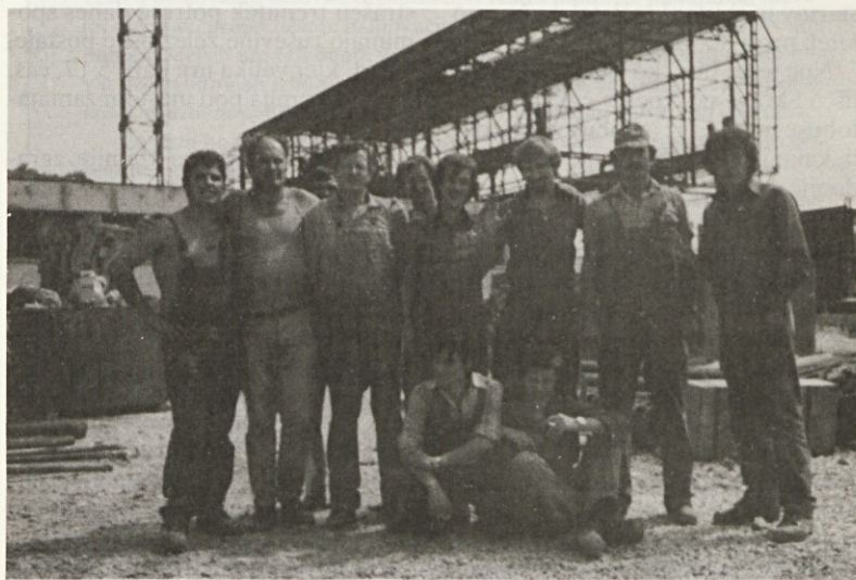
Montažna ekipa RHE Obrovac
