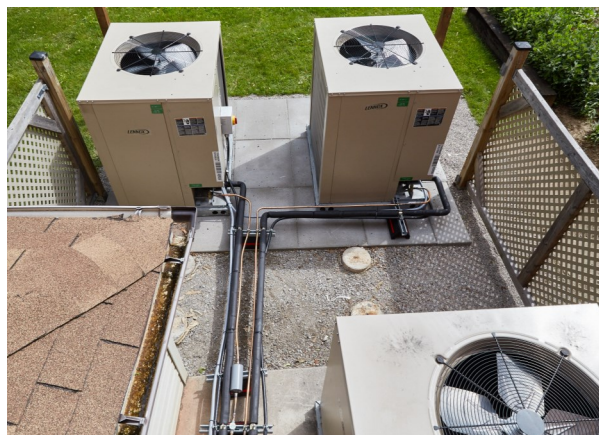
Novi enoti za hlajenje v ospredju, v ozadju enota za hlajenje spodnje dvorane obnovljen pred nekaj leti.
