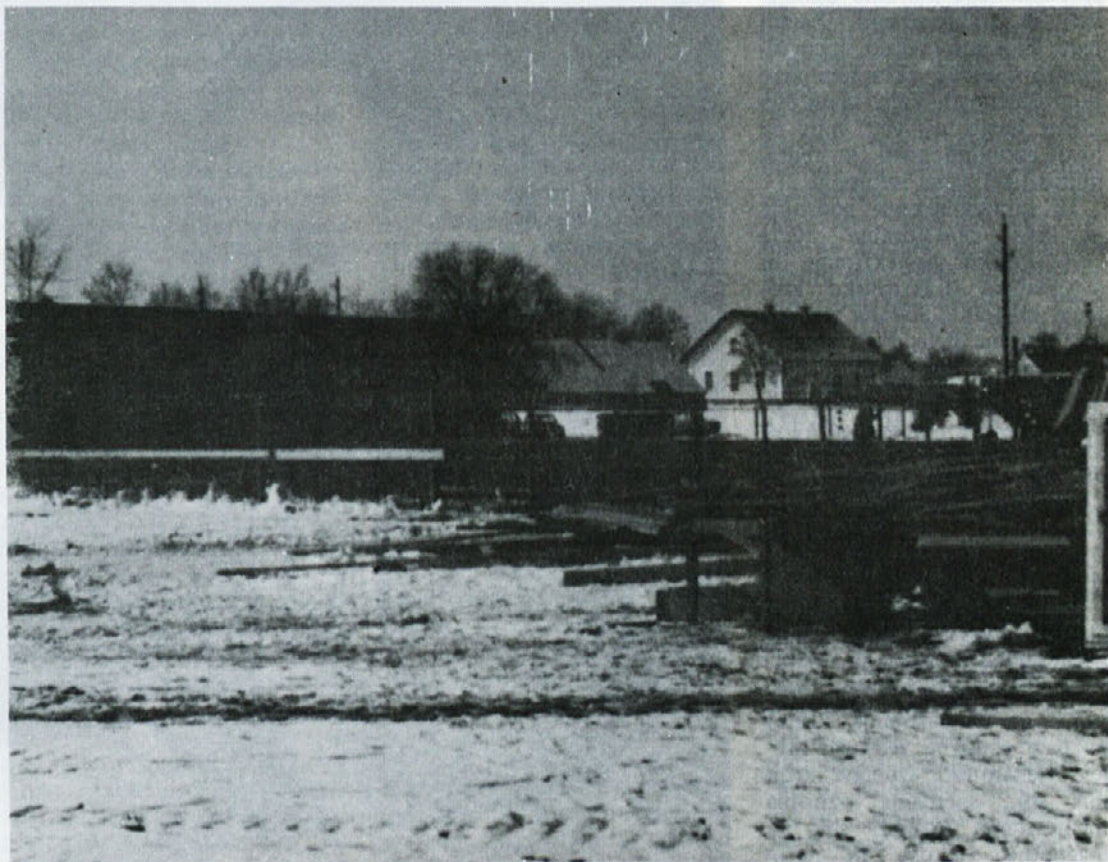
Z izgradnjo III. faze TOZD Delta so izvajalci začeli že v času ko se je sneg še trdo držal zemlje in streh. Prva dela so kazala vse najboljše, kasneje pa se je zataknilo. Vendar še vedno lahko upamo, da bo z največjimi napori dosežen rok.
