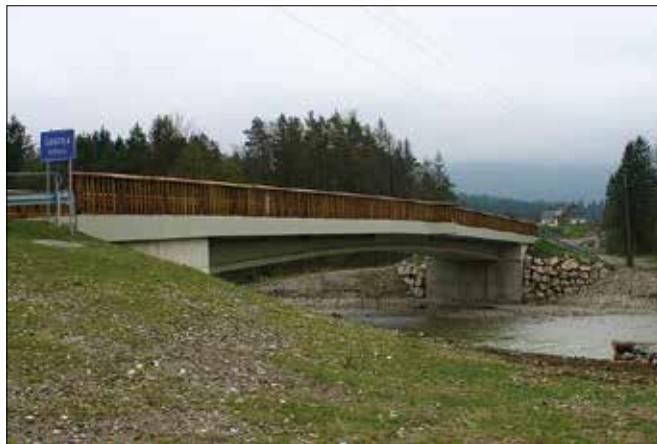
Na istem mestu so čez eno leto namenu predali novi most s povezovalnima cestama. Zaradi poplavne varnosti je bilo treba most dvigniti, drevje pa je dalo prostor cestama. (Foto: Marija Lebar)
