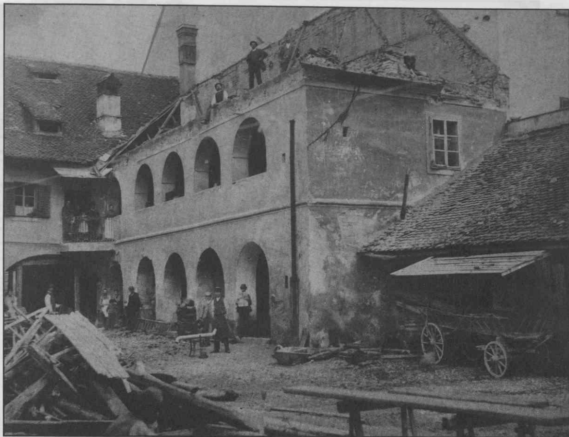
Od potresa prizadeta hiša na gradišču
