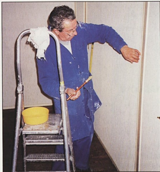
(Nica) Franci Drašček marljivo obnavlja stanovanje za prihajajočega novega izseljenkega duhovnika.
