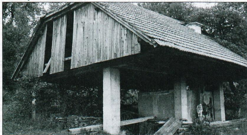
Brezdimna sušilnica v Malih Dolah pri Šentjurju.
