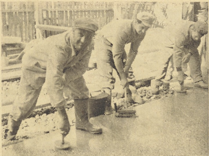
Kadar primanjkuje obrtnikov in teracerjev, si Mariborčani pomagajo za lastnimi zidarji. Na sliki skupina zidarjev pri polaganju teraca na objektu »samopostrežna restavracija«
