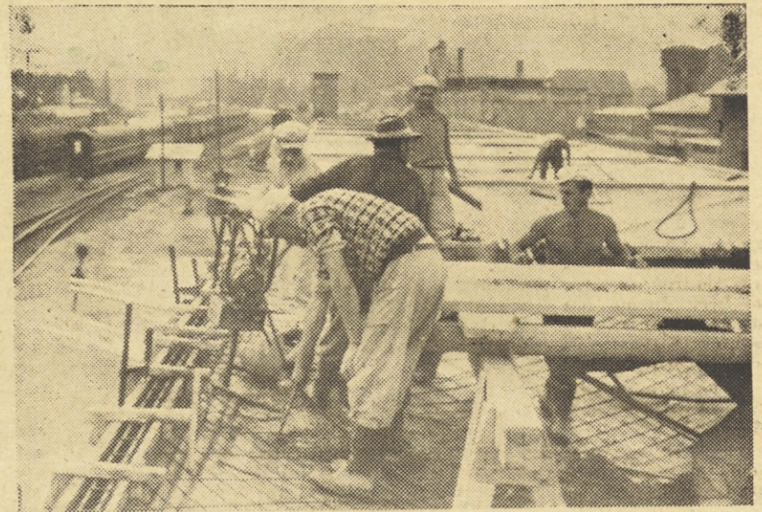
Kolektiv gradbenega vodstva Gradis Jesenice je prevzel dela na ljubljanskem kolodvoru. Dela zelo hitro napredujejo ter bodo kot izgleda še pred rokom zaključena
