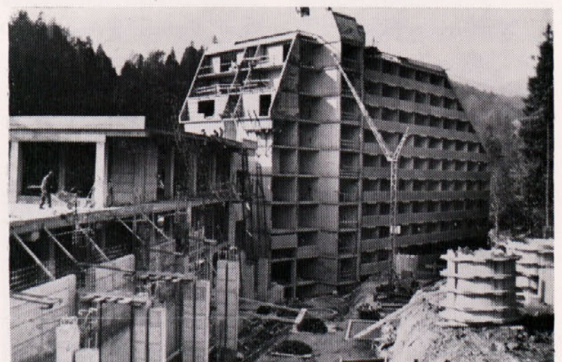
Dela na hotelu v Dobrni hitro napredujejo.
