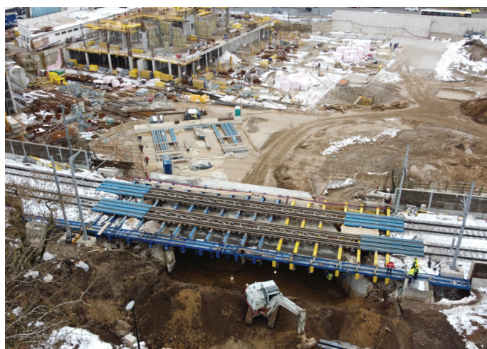
Slika 12. Začetek podrivanja (slika levo) in preboj ter sklepna faza podrivanja (slika desno).
