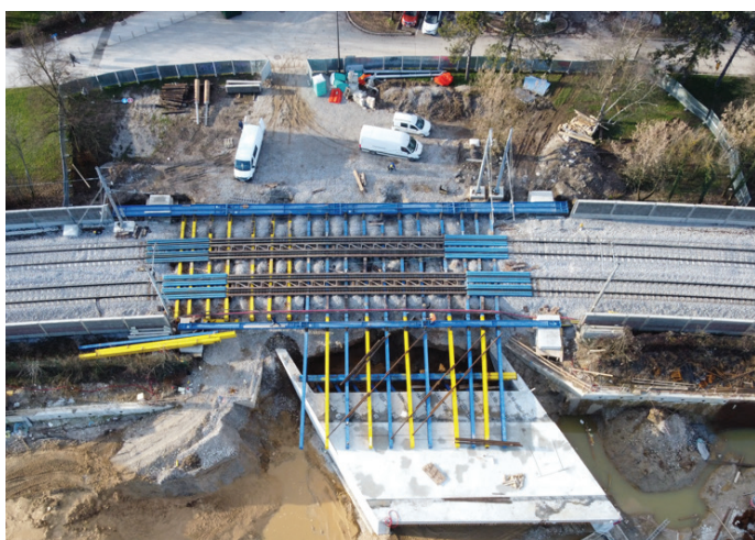
Slika 12. Začetek podrivanja (slika levo) in preboj ter sklepna faza podrivanja (slika desno).
