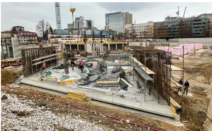
Slika 9. Izvedena temeljna plošča (slika levo) in betoniranje preklade (slika desno).
