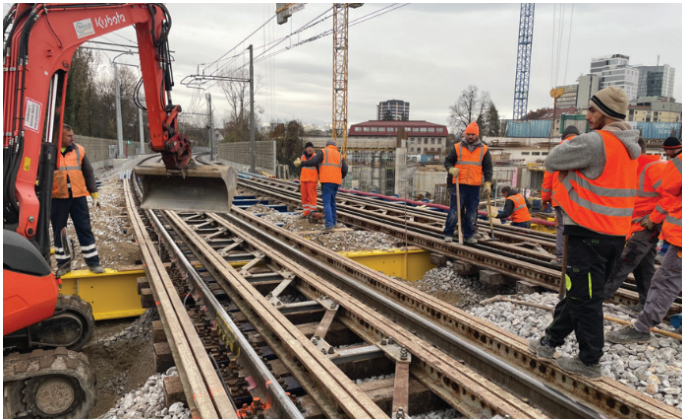
Slika 8. Vgradnja provzorijev in uvlačenje nosilcev pod trome med prometom (slika levo) ter delavnica (slika desno).
