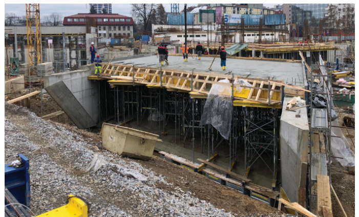
Slika 9. Izvedena temeljna plošča (slika levo) in betoniranje preklade (slika desno).
