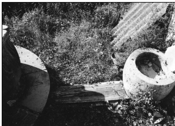
Enostavnejši odprti čistilnik na domačiji Kazlje 16. Voda je iz žlebov pritekla na kamenje v čistilniku, od tam pa po kanalu v tleh do vodnjaka. Foto: E. Bellingar, 2009.
