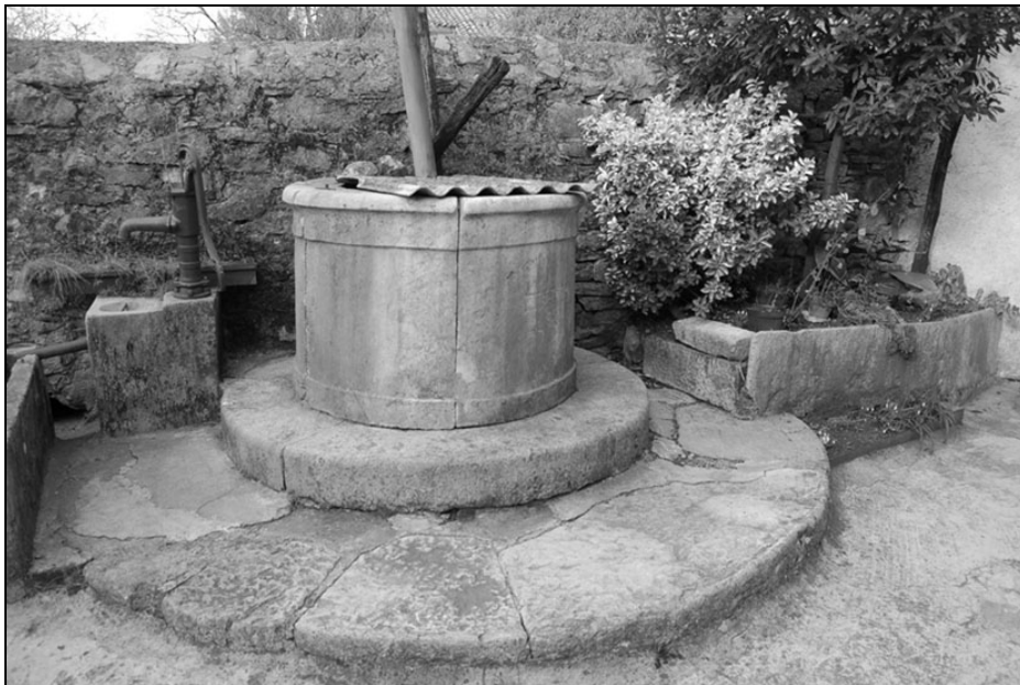
Na obod postavljen oklep z ravnimi stenami vodnjaka Drsalavih, Volčji Grad 12, obkrožen s škalinom. Foto: E. Belingar, 2012.
