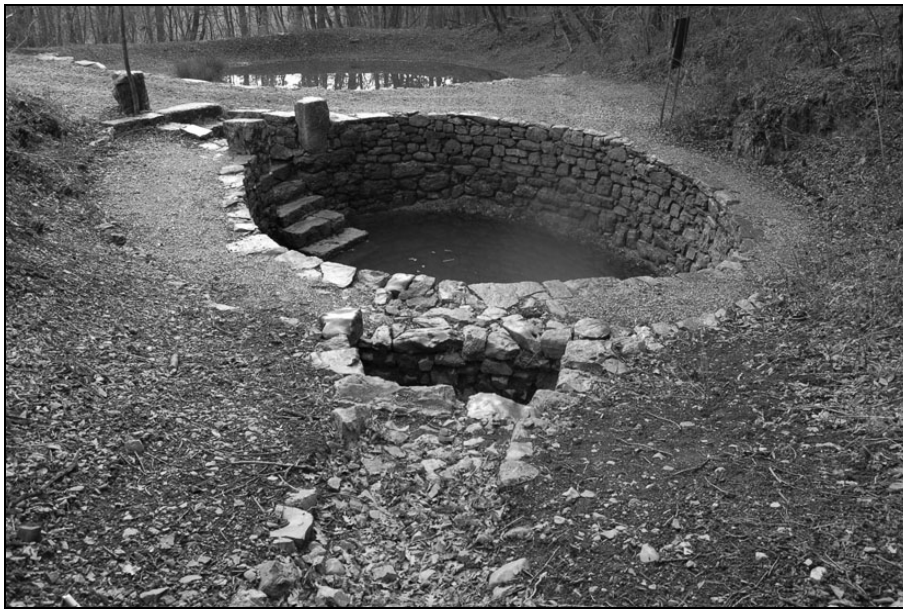
Hrpelje, Štirnica. Za dostop do vode so uredili stopnice, pred izpustom vode v štirnico pa čistilnik. Foto: E. Belingar, 2011.
