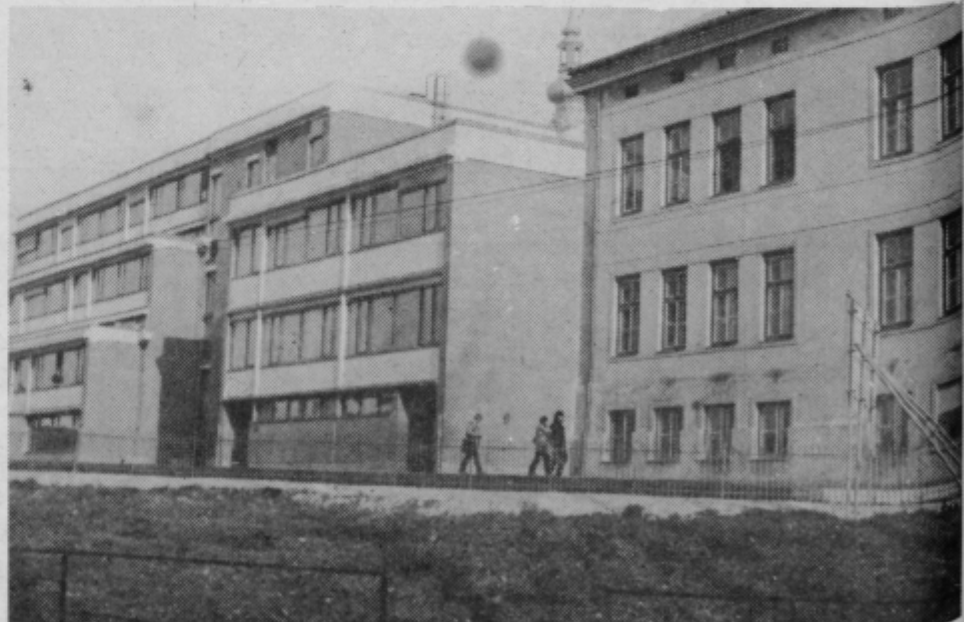
ŠENTJUR – Prizidek k osnovni šoli je zrasel iz sredstev II. samoprispevka. Nemogoče razmere v kuhinji, ki je v starem delu, pa terjajo takojšnjo sanacijo.
