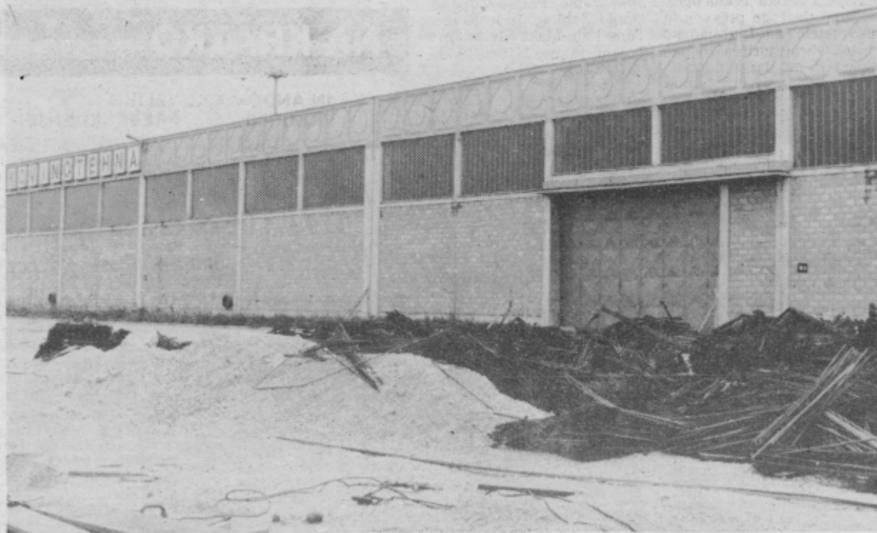
Del novih skladiščnih prostorov Kovinotehne na Zgornji Hudinji v Celju med gradnjo.
