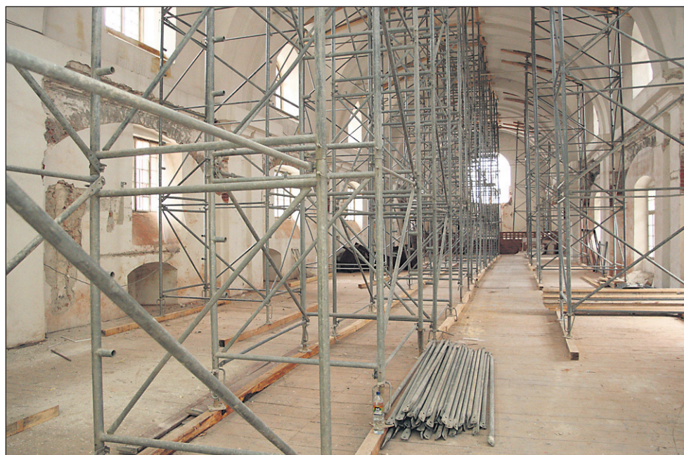
Obnova Dominikanskega samostana teče po načrtih.
